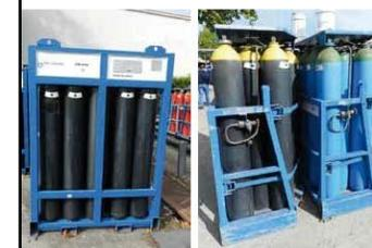
Tipos de recipientes: conjuntos de 16 botellas B50 inter-conexionadas entre sí mediante un colector y terminando en una válvula de descarga.
